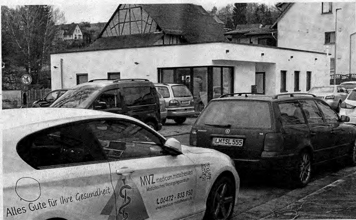
Mitten im alten Ortskern von Münster liegt das neue Medizinische Zentrum.
